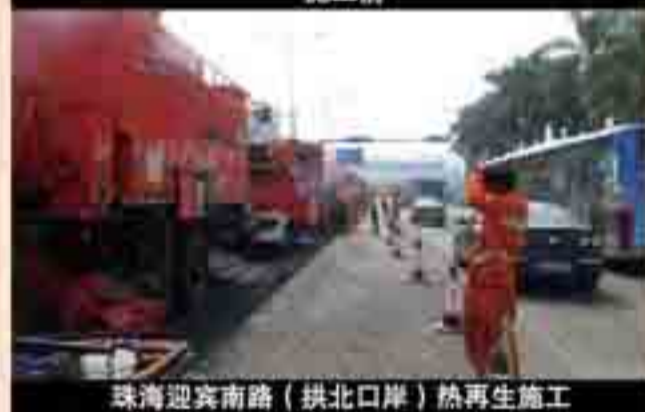
珠海迎宾南路(拱北口岸)热再生施工
