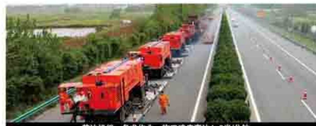
英达机组一条龙作业，施工速度高达4-6米/分钟
