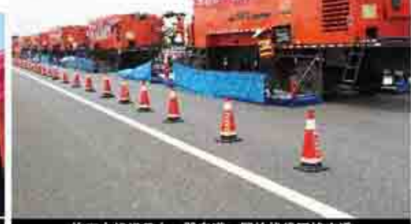
施工中机组只占一股车道，国检战役不扰交通
