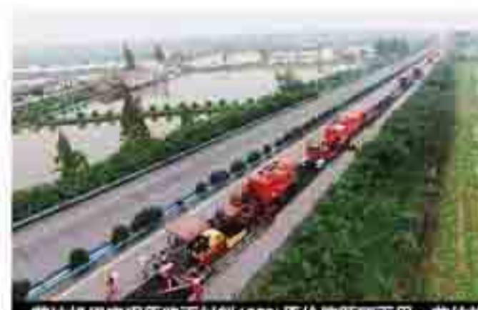
英达机组实现原路面材料100%原价值循环再用，节约施工成本
