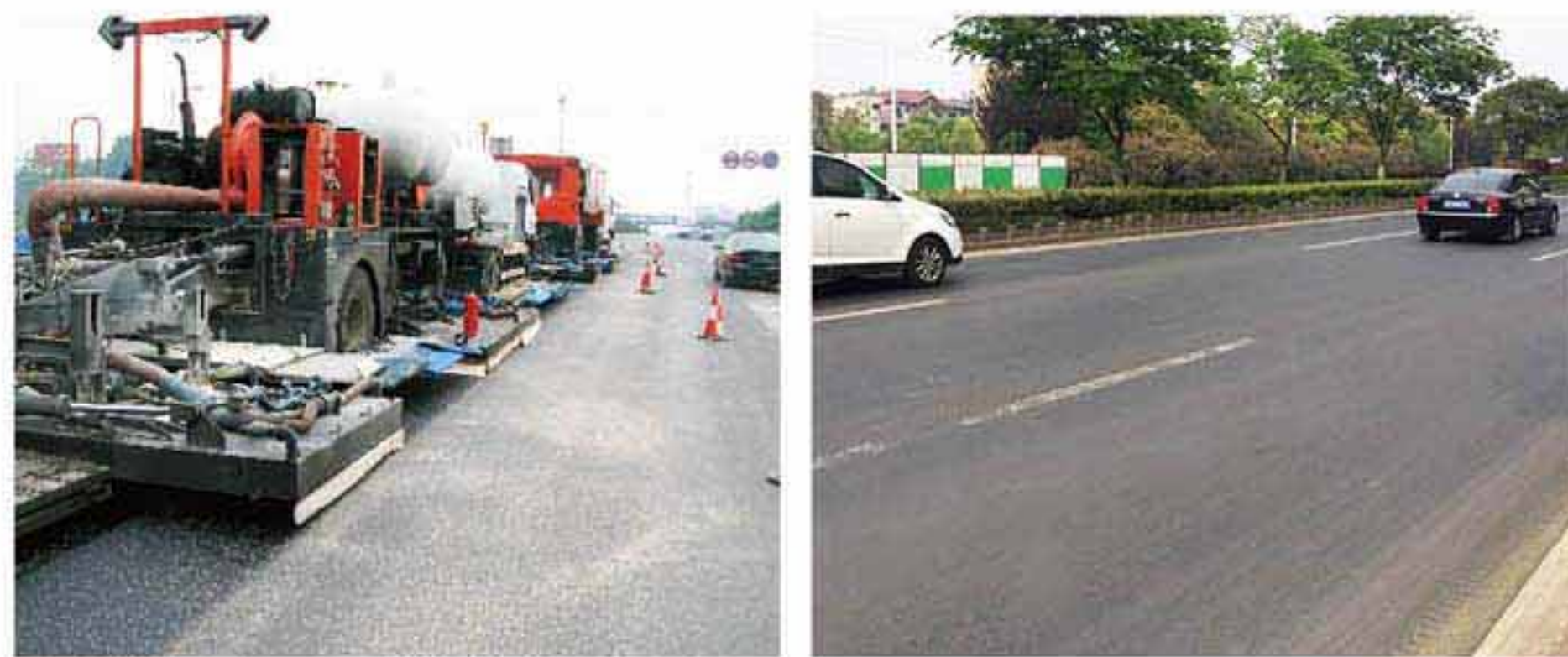
2008年英达玄武大道施工现场
