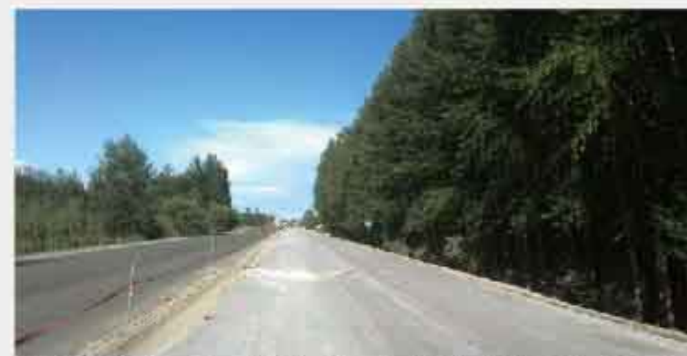
传统水泥冷再生工艺采用土工布/薄膜覆盖洒水方式养生
