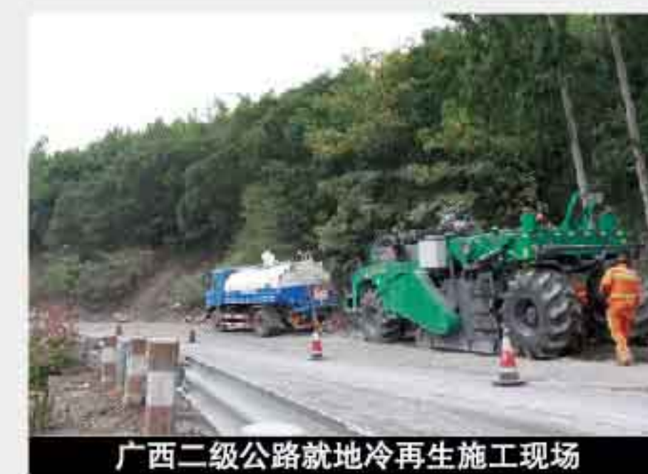
广西二级公路就地冷再生施工现场
