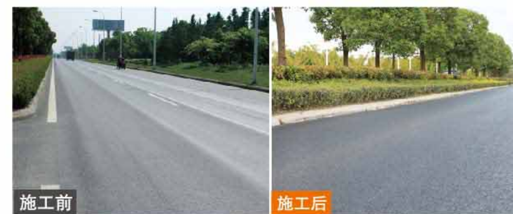
施工前后对比：深达9厘米的重度车辙，机组驶过后一扫而光
