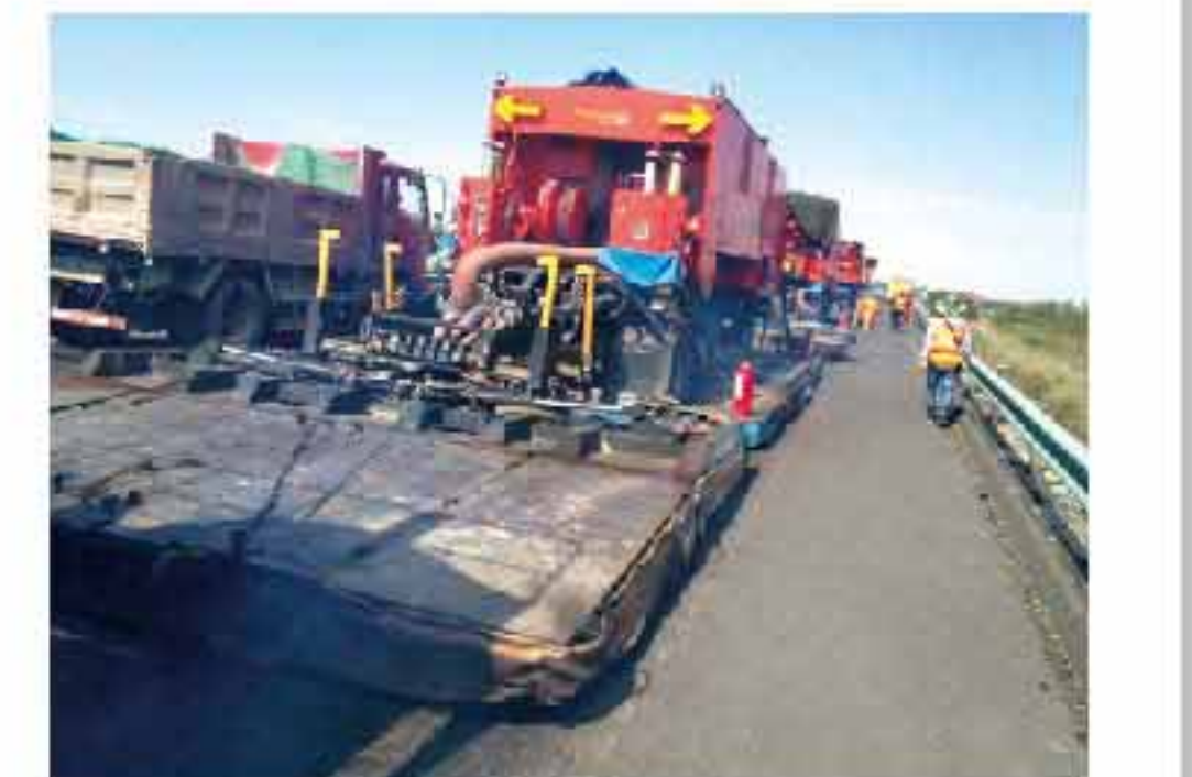
英达复拌热再生工艺，优化级配，提升路用性能
