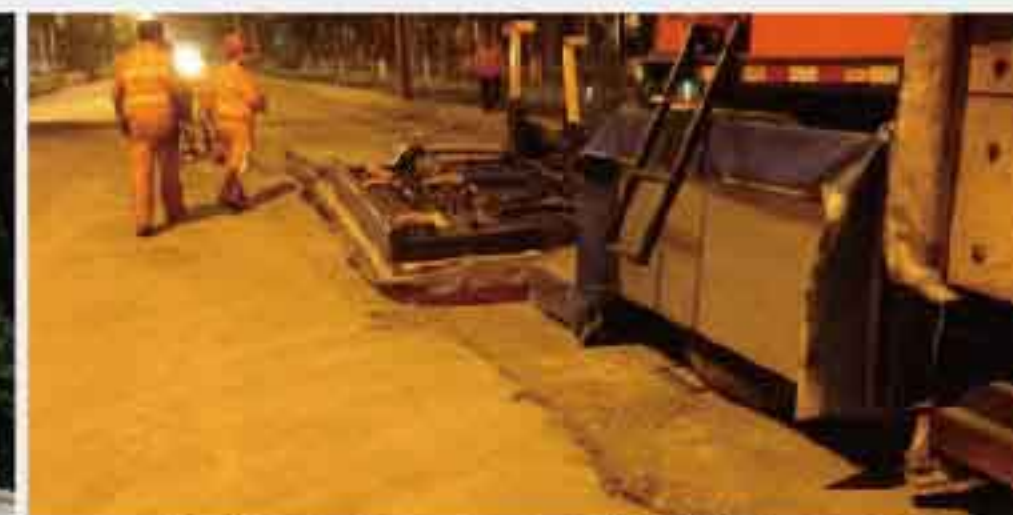
英达HM16对冷再生层加热烘烤使其快速固化
