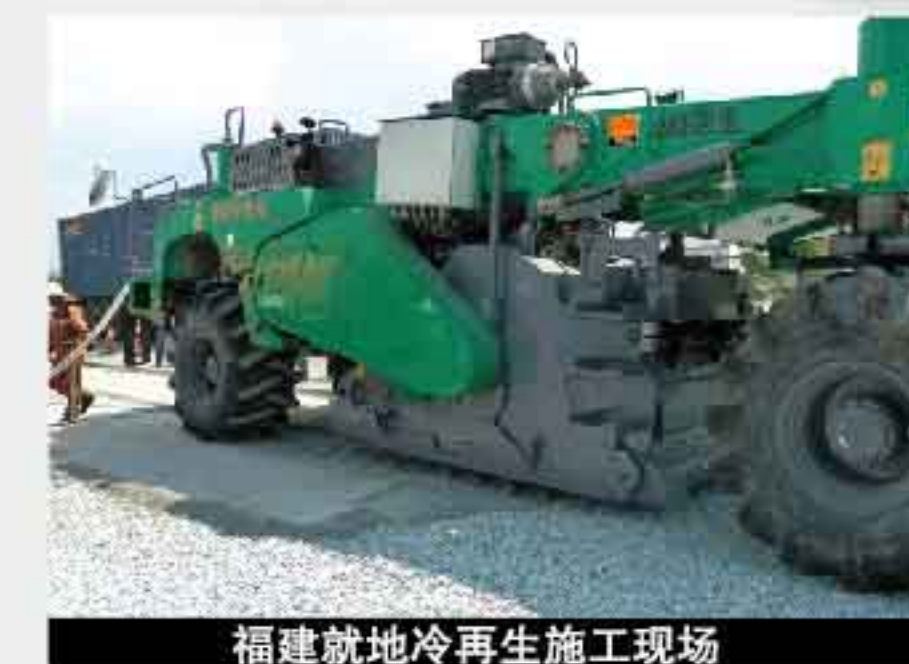
福建就地冷再生施工现场
