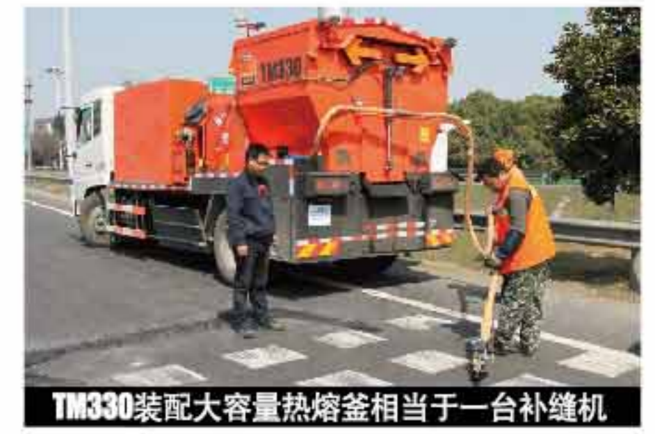
TM330装配大容量热熔釜相当于一台补缝机
