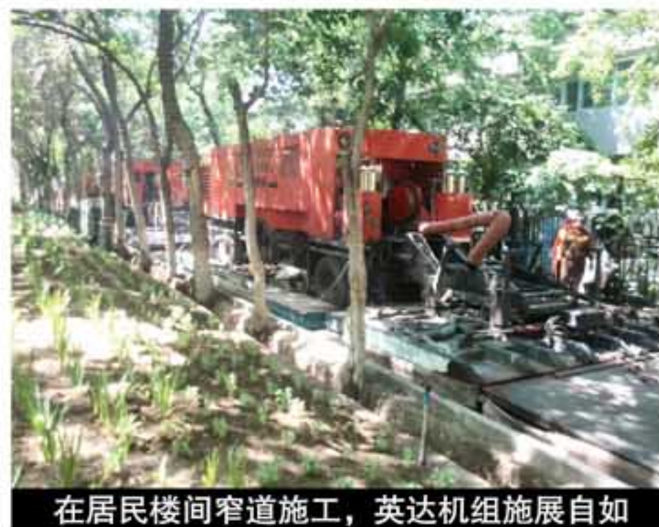
在居民楼间窄道施工，英达机组施展自如
