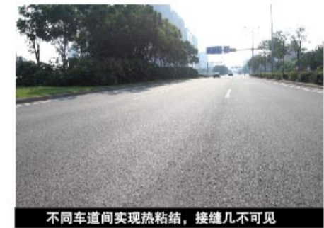
不同车道间实现热粘粘，接缝几不可见
