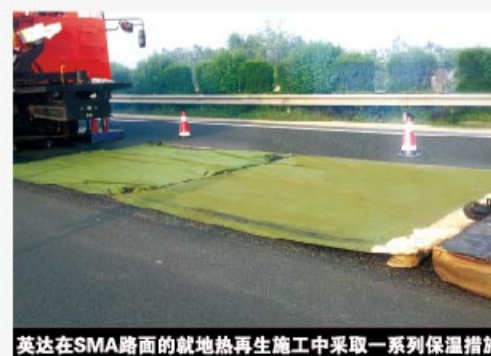
英达在SMA路面的就地热再生施工中采取一系列保温措施
