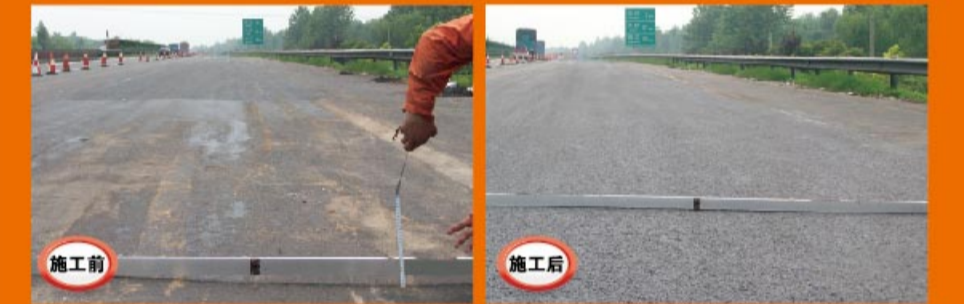
英达热再生对润扬大桥车辙路病进行治理
