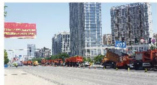
▲低碳节能，无扬尘无噪音无污染“公路医生”优雅施工
