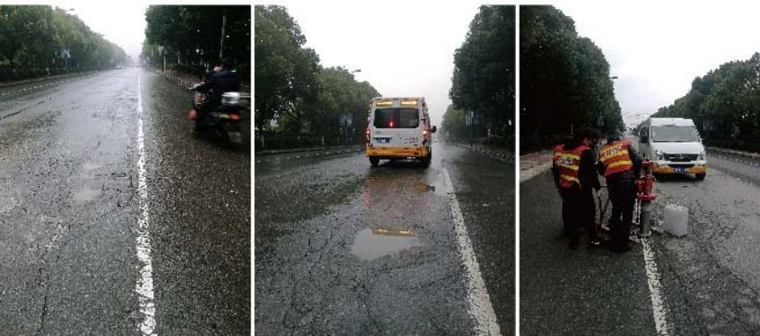
根据路面病害分析、弯沉检测结果,以及交通量情况,判断病害主要发生在基层和面层,适合采用基层加固普通型地聚物注浆材料,注浆深度40cm。
